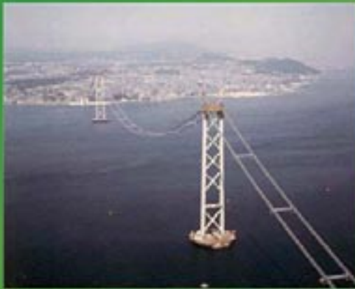
Pylone (Höhe 283m) mit Tragkabel (Durchmesser 1,12 Meter)
